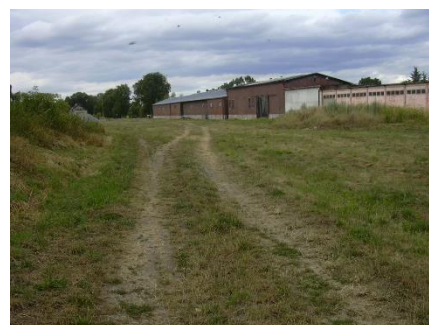
Staré nádražní skladové budovy bez kolejí.
