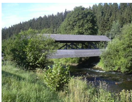
Krytý dřevěný most přes řeku Úpu v Havlovicích.
