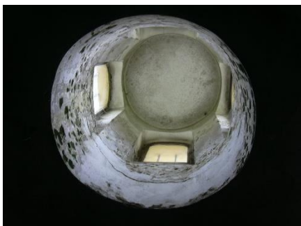
Lucerna nad spojovací chodbou do sousední budovy sociálních služeb.
