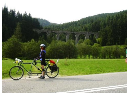
Železniční viadukt u obce Telgart.
