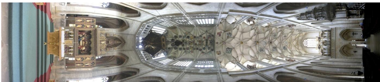
Skvostný strop se síťovou klenbou v hlavní lodi
