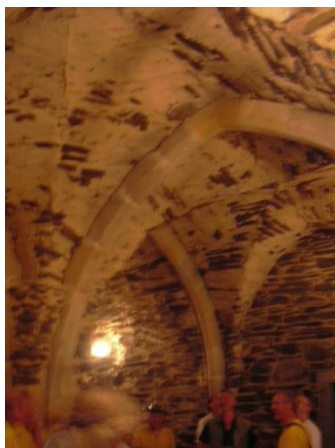
Prastará sklepní klenba, ze které doposud čouhají i zazděná prkna z původního bednění ze 13. století.
