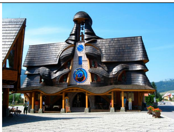
Orloj ve Starej Bystrici
