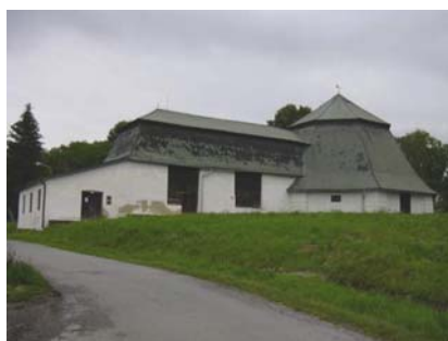
Budova pro těžbu solanky
