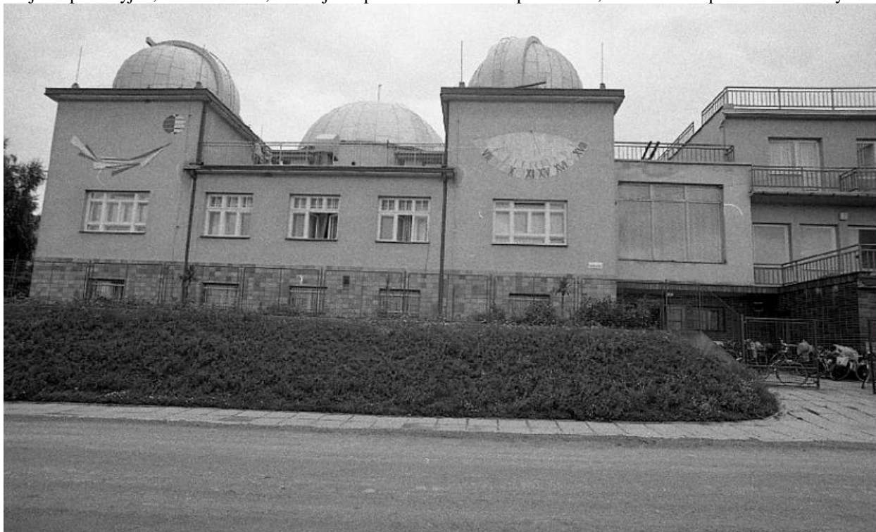
obrázek 9.: hvězdárna ve Ždánicích - fotka vypůjčena z EBI 1986
