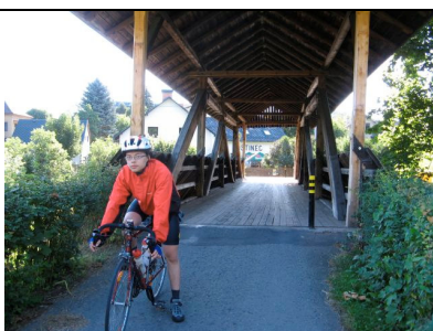
celodřevěný most v Havlovicích
